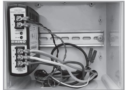
Emplacement des fils de connexion de l'interrupteur à flotteur du boîtier de commande.
