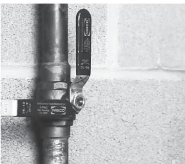
O. Après l'installation des composants de dérivation, mais avant le raccordement des systèmes, rincer les conduites en ouvrant brièvement les valves correspondantes pour rincer les débris résultant de l'installation. Une bonne pratique est de rincer avec suffisamment d'eau pour remplir un seau de 18,9 L. Ensuite, refermer les valves.
