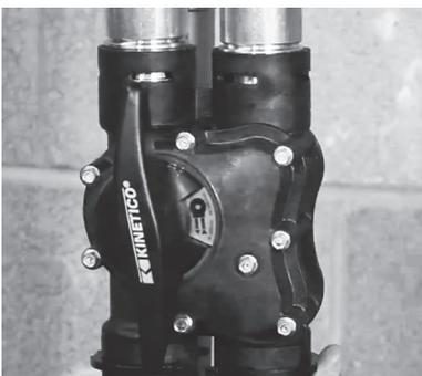
N. Raccorder l'ensemble de la valve de dérivation sur les adaptateurs de plomberie en utilisant les attaches fournies. S'assurer que les attaches sont complètement logées dans toutes les fentes.
